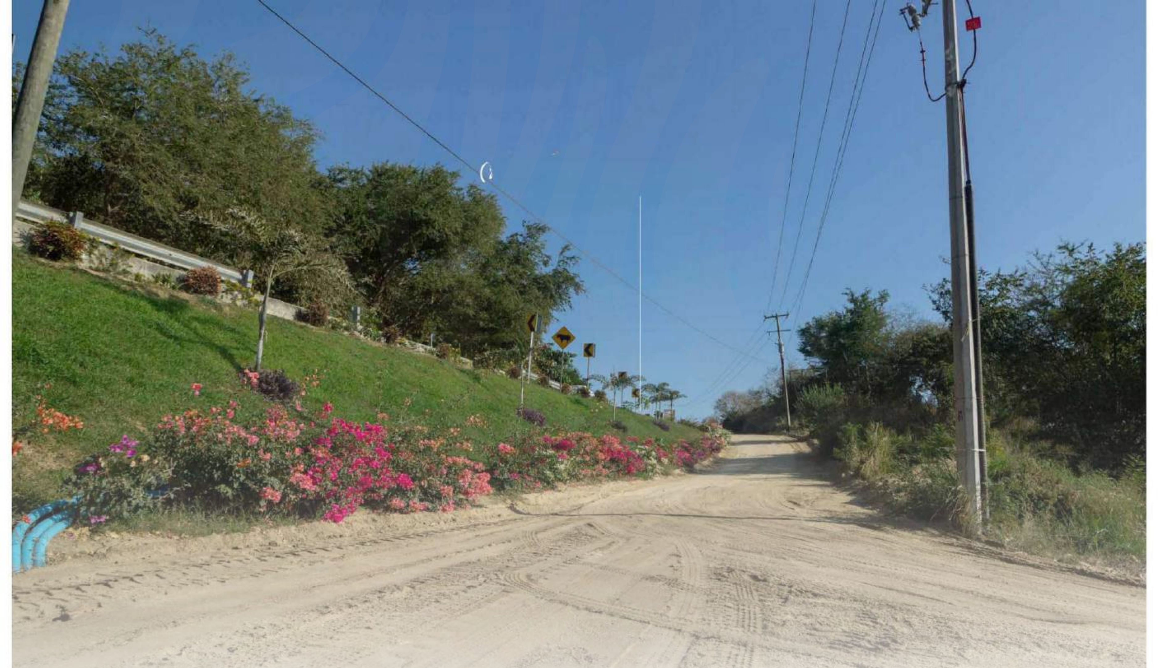
vista ingreso carretera 200
