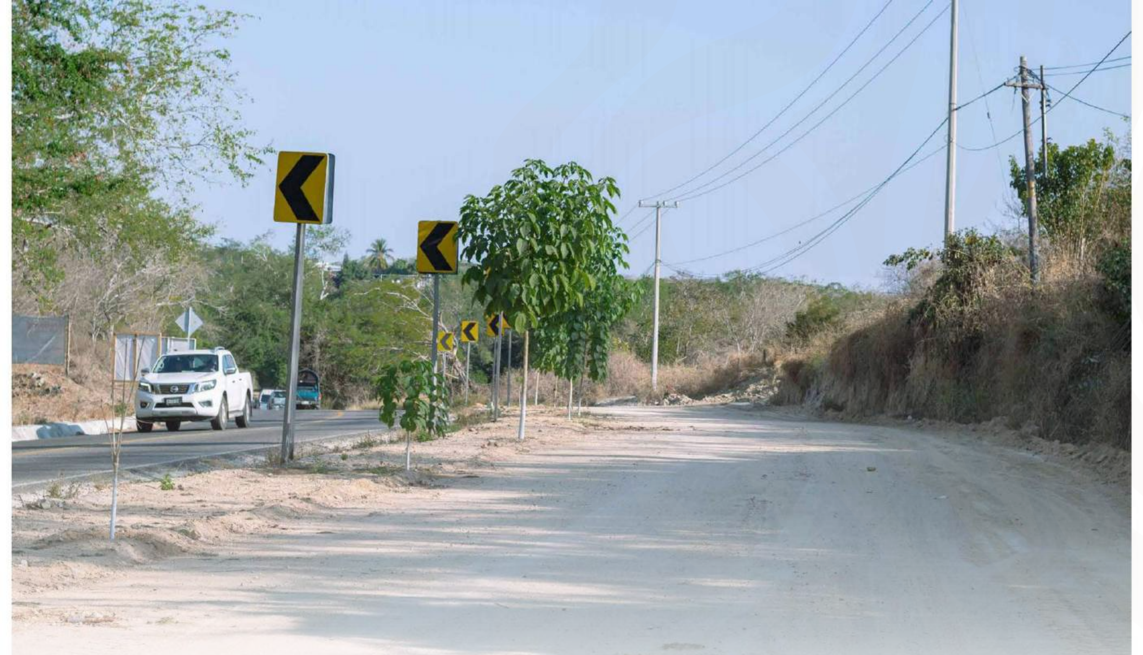
vista ingreso carretera 200
